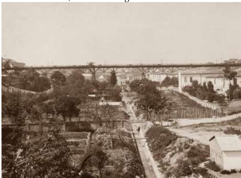
Figura 11-3 Guilherme Gaensly, Vale do Anhangabaú e Viaduto do Chá, com o Anhangabaú canalizado
