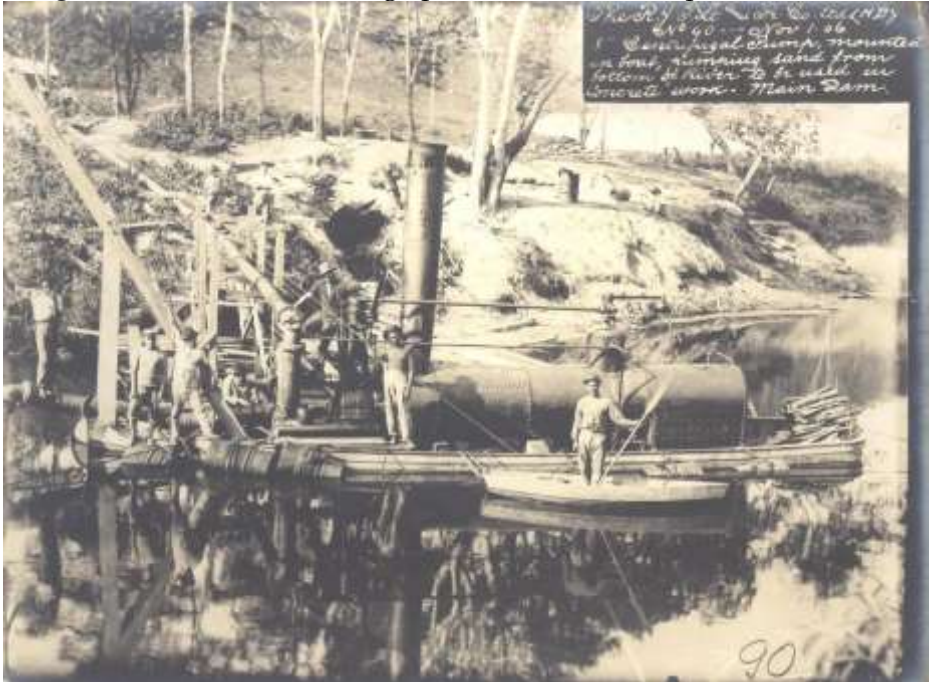
Figura 10-7 Bomba centrífuga para transferir areia para o concreto
