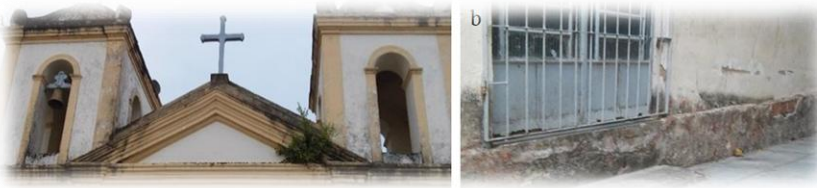
Figura 15 a, b – Estado de conservação da edificação.
