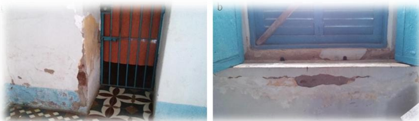
Figura 14 a, b – Estado de conservação da edificação.
