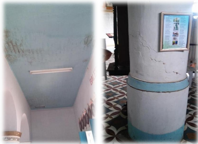
Figura 16-17 – Estado de conservação da edificação
