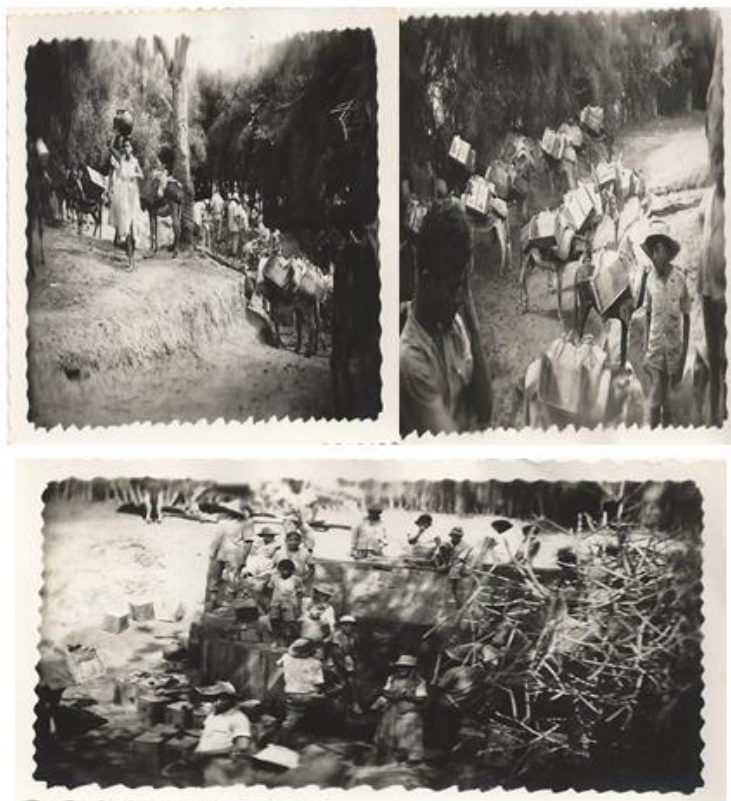
Fotografia 15 - Abastecimento de água em Palmeira dos Índios (1940) com água do açude na Mata da Cafurna
