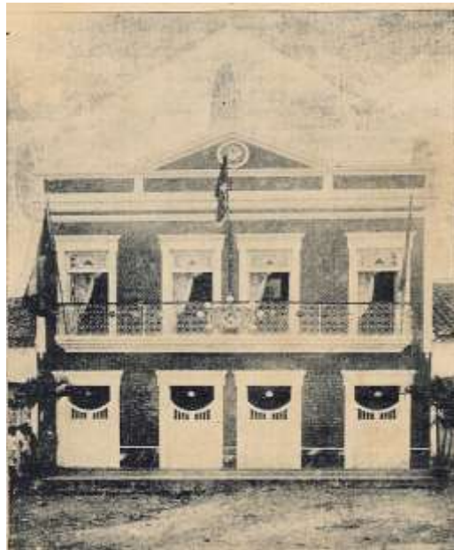
Foto 2- Fachada da Loja Fraternidade e Progresso cidade de Goiana-PE
